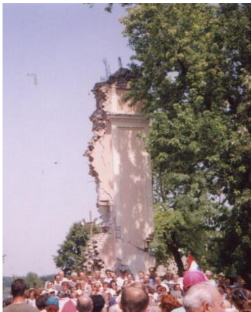
Porušena crkva u Aljmašu
